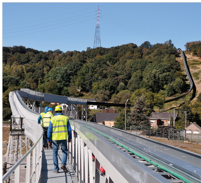
Realizace zakázky na příhradovém pásovém dopravníku v rozsahu 18 000 m 2 povrchově upravované plochy trvala necelých šest měsíců.
