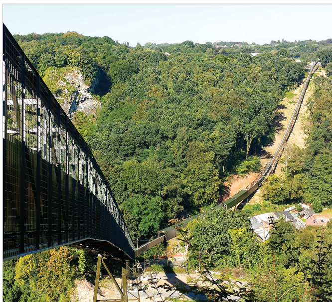
Realizace zakázky na příhradovém pásovém dopravníku v rozsahu 18 000 m 2 povrchově upravované plochy trvala necelých šest měsíců.
